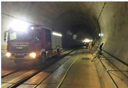
LF KatS von Mühlhausen im Steinbühl tunnel bei einem Test der Wasserversorgung
