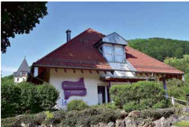
Evang. Martinshaus Gruibingen, Mühlhauser Straße 3
