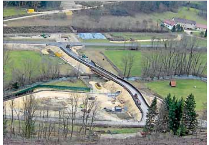
Baustelle für die Filstalbrücke
