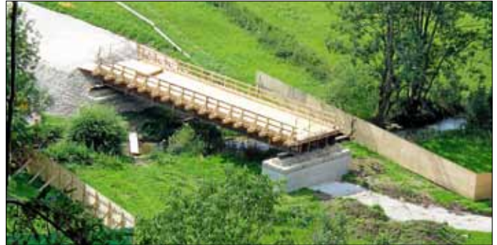
Brücke über Fils fertiggestellt
