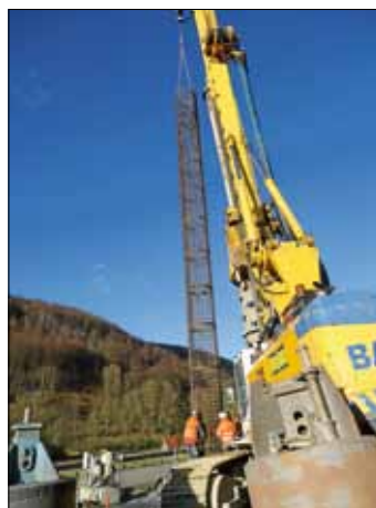
Filstalbrücke: Bohrarbeiten an der L1200
